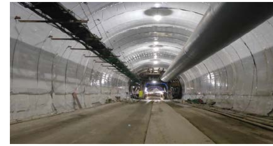
ニツ森トンネル(鹿子)他 防水工施工完了状況
