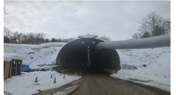
21.内浦トンネル(東川) 本坑状況
